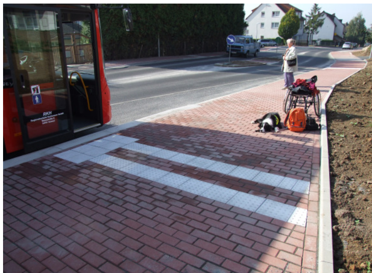
Abb.8: Bushaltestelle in Schauenburg-Breitenbach, mit 2 im Abstand verlegten Reihen Noppenplatten als Auffangstreifen und dem Einstiegsfeld mit Rillenplatten, im Hintergrund die Querungsstelle
