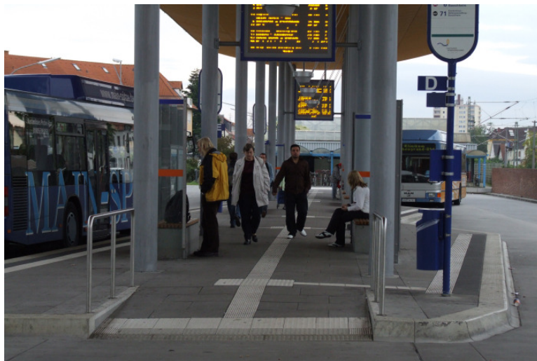
Abb.5: Busbahnhof Rüsselsheim. Bei größeren Anlagen führen Leitstreifen zur Einstiegsstelle
