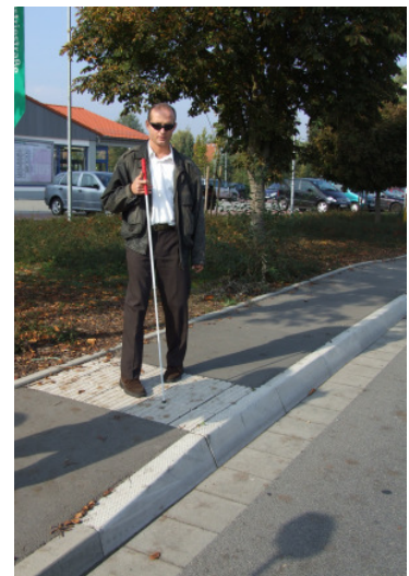
Abb.9: Hofgeismar Bei Bushaltestellen auf schmalem Gehweg ist der Einsatz von zwei verschiedenen Bodenindikatoren nicht sinnvoll.
