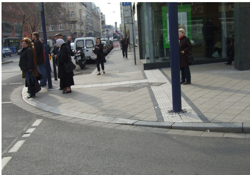
Abb. 13: Querungsstelle in Offenbach mit Nullabsenkung. Auffindestreifen leiten Blinde zum Ampelmast. Ein dunkler Begleistreifen sorgt für optischen Kontrast.
