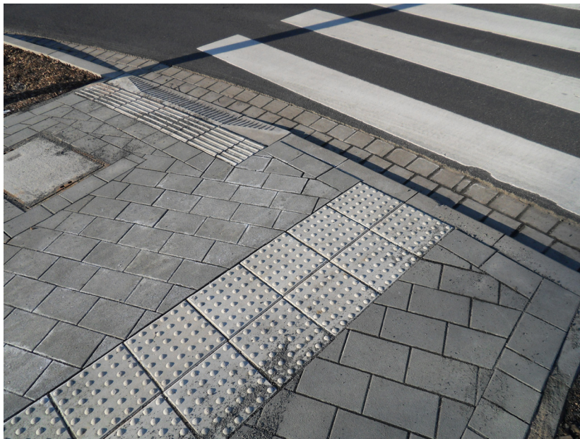
Abb.4: Querungsstelle in Stadtallendorf mit differenzierter Bordhöhe. Nullabsenkung mit Rollbord und Sperrfeld zur Absicherung für Blinde
