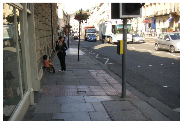
Durch Lichtsignal gesicherte Querungsstelle in Bath mit roten Noppenplatten und Auffindestreifen
