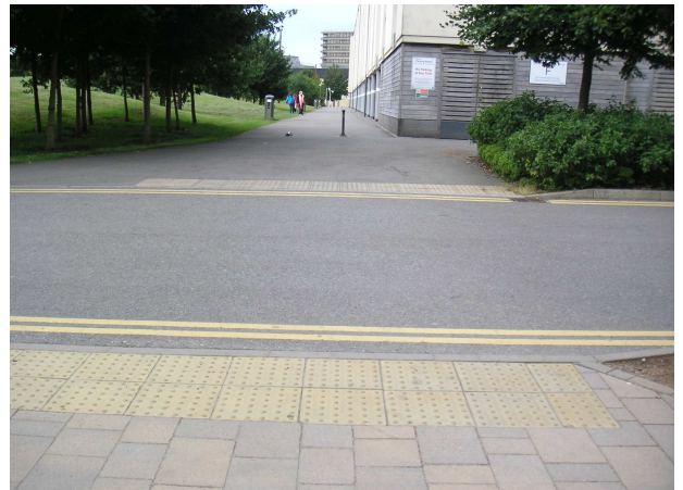
Bordabsenkung in der University of Bath, abgesichert mit gelben Noppenplatten
