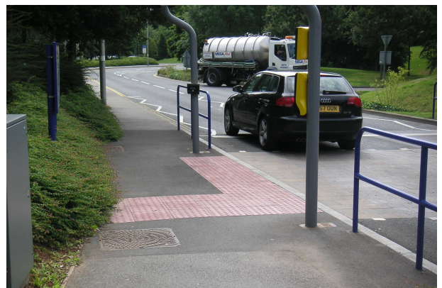
Durch Lichtsignal gesicherte Querungsstelle in der University of Bath mit roten Noppenplatten und Auffindestreifen
