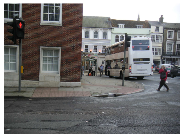
Durch Lichtsignal gesicherte Querungsstelle in Winchester, schräg angeordnete Noppenplatten für seitliche Querung
