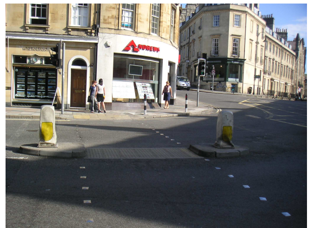
Ungesicherte Querungsstelle in Bath mit gelben Noppenplatten am Gehwegrand und auf der gesamten Mittelinsel
