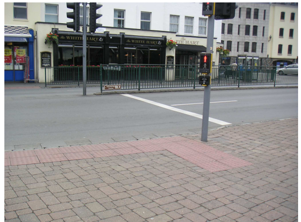
Durch Lichtsignal gesicherte Querungsstelle auf Guernsey mit Noppenplatten. Der optische Kontrast ist hier kaum gegeben.
