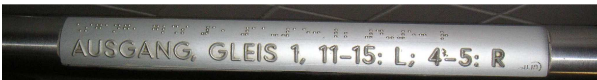
Abb. 16: Handlaufbeschriftung, oben in Prismenschrift, auf der Rückseite in Brailleschrift.
