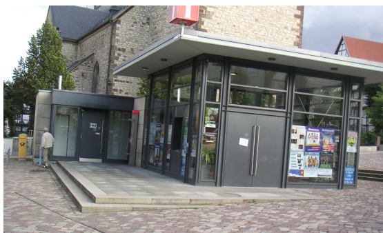
Abb. 6: Solche auslaufende Stufen ohne Kontraste können selbst für sehende Passanten zur Stolperfalle werden.
