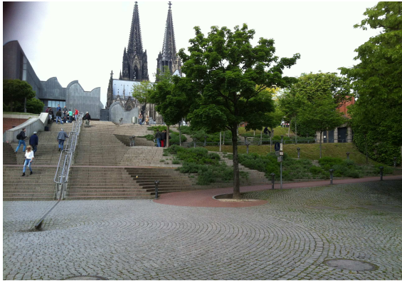
Abb. 13: Treppe zur Domplatte in Köln. Die Führung zum Handlauf in der Treppe Mitte erfolgt über ein Metallelement im Boden. Für Menschen, die auf Rollstuhl oder Rollator angewiesen sind, dient der Weg rechts als Verbindung.
