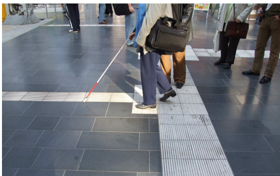
Abb. 15: Leitsystem im Hauptbahnhof Frankfurt. Die Breite der Leitstreifen wurde nach Bedeutung der Verbindung differenziert.
