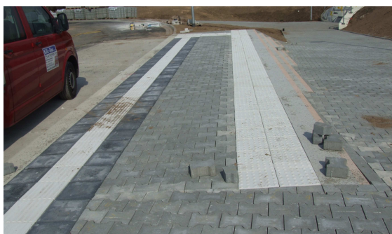
Abb. 7: Am Bahnhof Mörfelden wurden oberhalb der Stufen Noppenplatten verlegt, die Stufenkantenmarkierung ist allerdings nicht ausreichend kontrastreich.
