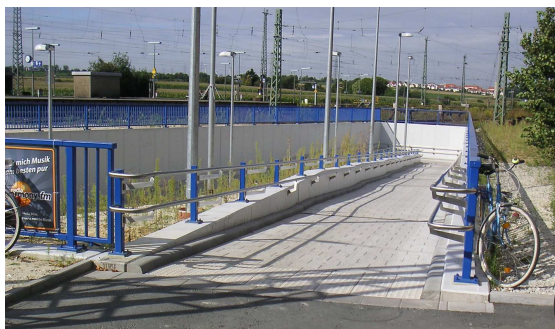
Abb. 4: Lange Rampenanlage zu einer S-Bahn-Unterführung in Bad Vilbel
