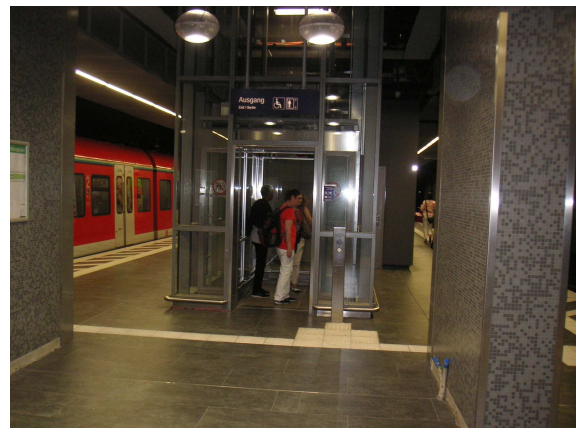
Abb. 1: Leitsystem in der S-Bahn Frankfurt. Der Leitstreifen führt zum Aufzugstaster, der an der Stele gut auffindbar ist. Durch die Stützenstellung ist der Raum sehr knapp, der Leitstreifen quer über den Bahnsteig liegt deshalb eigentlich zu dicht am Aufzug.
