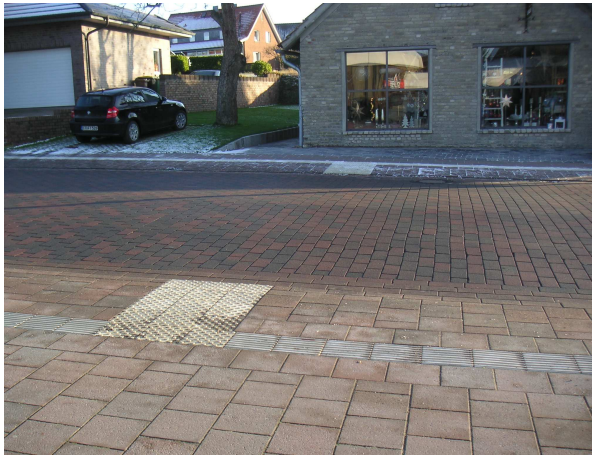
„Shared Space“ in Bohmte. Bodenindikatoren markieren eine Querungsmöglichkeit. (Quelle: Bernhard Kohaupt, Johannes Kohaupt. Barrierefreie Verkehrs- und Außenanlagen, Köln 2015)
