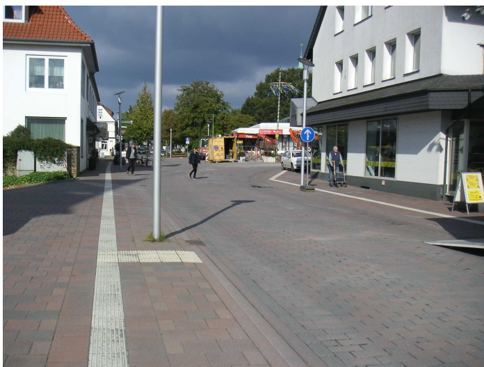
„Shared Space“ in Bohmte. Bodenindikatoren markieren eine Querungsmöglichkeit. Die Bodenindikatoren rechts sind durch eine Laderampe verdeckt. Der Mann mit Rollator bleibt dicht an der Hauswand. (Quelle: Bernhard Kohaupt, Johannes Kohaupt. Barrierefreie Verkehrs- und Außenanlagen, Köln 2015)
