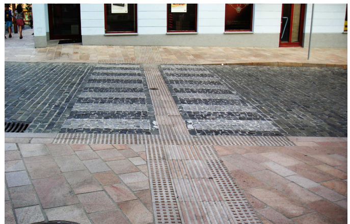
Noppenplatten vor Bordabsenkung und Leitstreifen im Auffinde- und im Zebrastreifen in Levoča (Slowakei)
