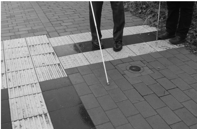
Auffindestreifen mit auseinandergelegten Noppen an Haltestelle in Mörfelden-Walldorf (Hessen)
