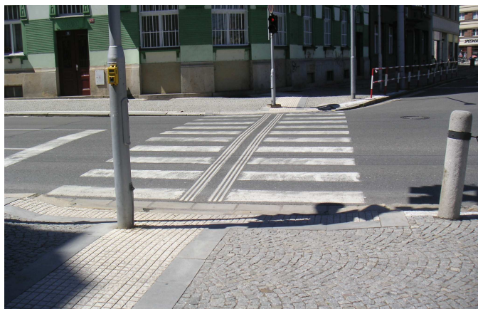
Noppenplatten vor Bordabsenkung und Leitstreifen im Zebrastreifen in Liberec (Tschechien)
