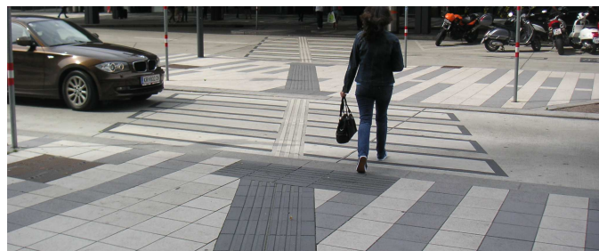
Querungsstelle mit Auffindestreifen und Leitstreifen im Überweg in Wien
