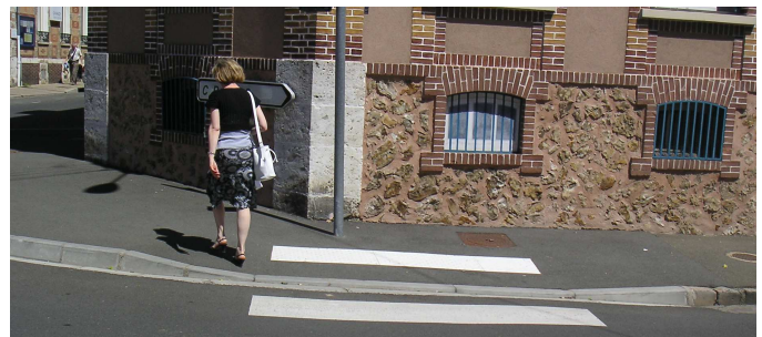
Noppenplatten vor Bordabsenkung in Chartres (F)
