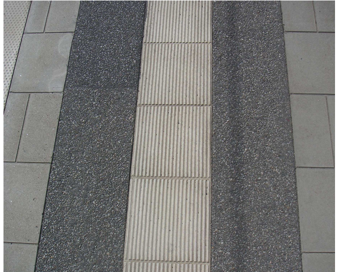
„Sinusrillen“ nach alter DIN 32984 von 2000
