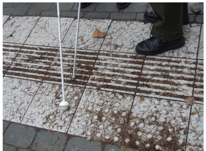
Auffindestreifen mit integriertem Richtungsfeld an Querungsstelle in Mörfelden (Hessen)
