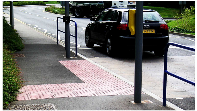
Noppenplatten vor Bordabsenkung in Bath (GB)
