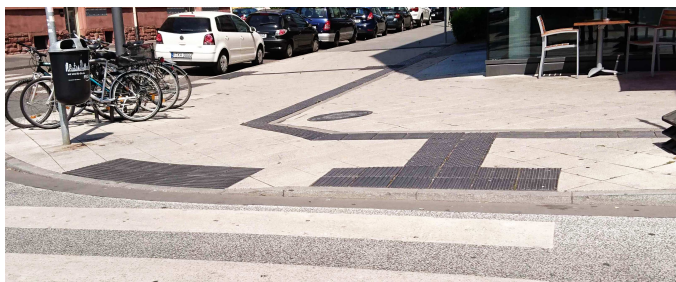
Querungsstelle mit Auffindestreifen im Leitsystem, Richtungs- und Sperrfeld in Frankfurt
