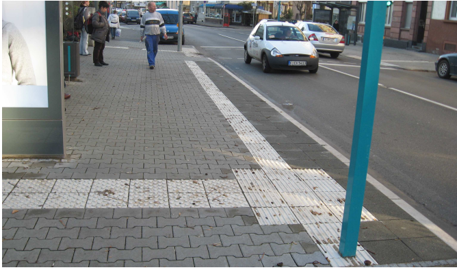
Einstiegsfeld mit Rippen, Noppen im Auffindestreifen in Frankfurt
