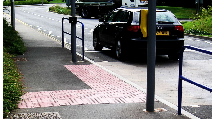
Noppenplatten vor Bordabsenkung in Bath (GB)
