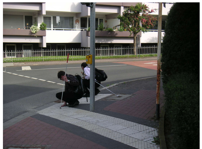
Auffindestreifen mit integriertem Richtungsfeld an Querungsstelle in Bad Homburg (Hessen)
