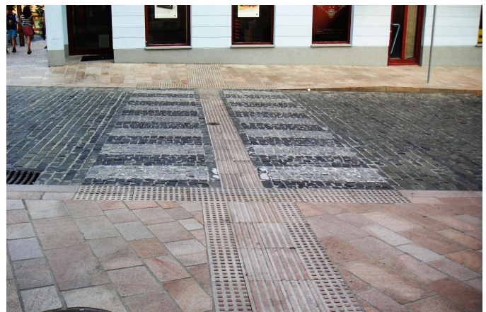
Noppenplatten vor Bordabsenkung und Leitstreifen im Auffinde- und im Zebrastreifen in Levoča (Slovakei)
