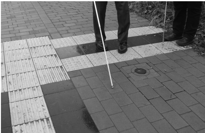
Auffindestreifen mit auseinandergelegten Noppen an Haltestelle in Mörfelden-Walldorf (Hessen)
