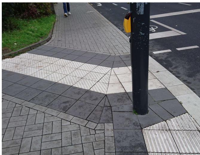
Querungsstelle in Fulda. Das Richtungsfeld weist die Querungsrichtung
