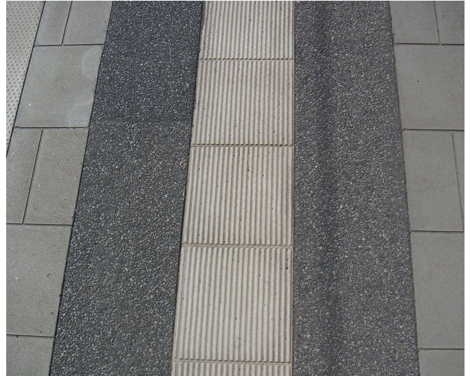
„Sinusrillen“ nach alter DIN 32984 von 2000
