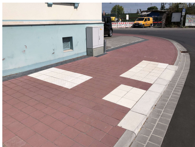
Verkürzter Auffindestreifen an ungesicherter Überquerungsstelle in Gernsheim (Hessen)
