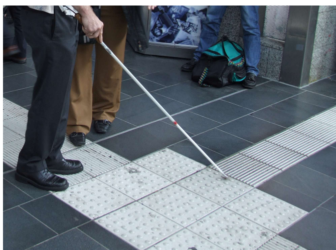
Leitsystem mit Abzweigefeld, Hauptbahnhof Frankfurt. Heute wären die Rippen breiter und die Noppen diagonal
