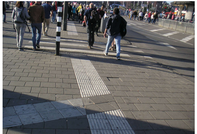
Noppenplatten vor Bordabsenkung und Abzweigung ohne Noppen im Leitsystem in Ansterdam (NL)
