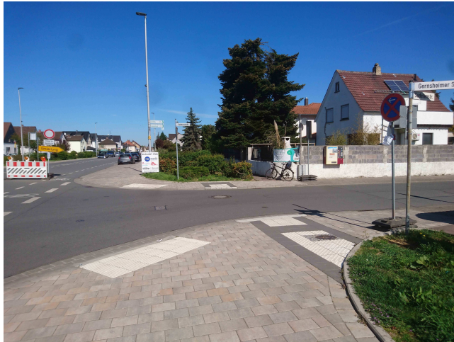
Ungesicherte Überquerungsstelle in Biebesheim mit verkürztem Auffindestreifen gemäß DIN 32984:1019-12
